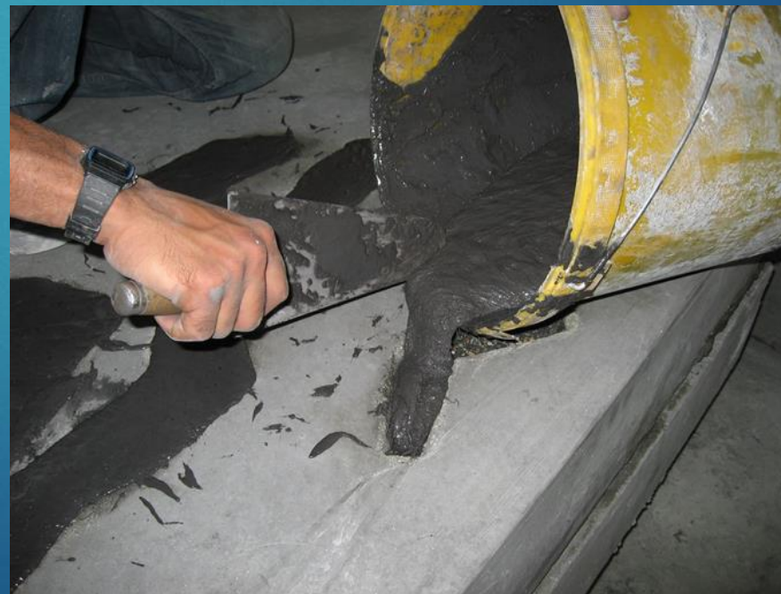
Dalles en béton avec inclusions en BFUP
