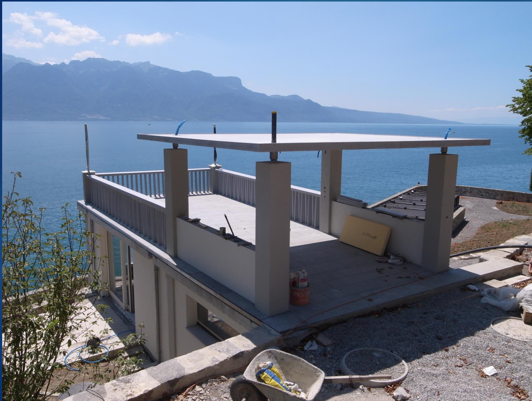
Dalle toiture. Épaisseur 6 à 9 cm. Dimensions 4.10 x 4.90 m
